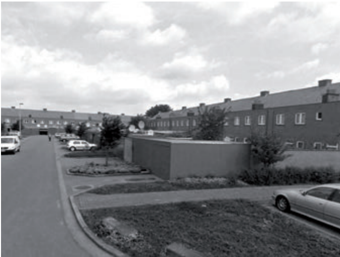
Afbeelding 1: Cit  in Heusden-Zolder, gebouwd in een binnengebied. De foto toont de publieke ruimte waaraan de achtergevels van de woningen grenzen.
